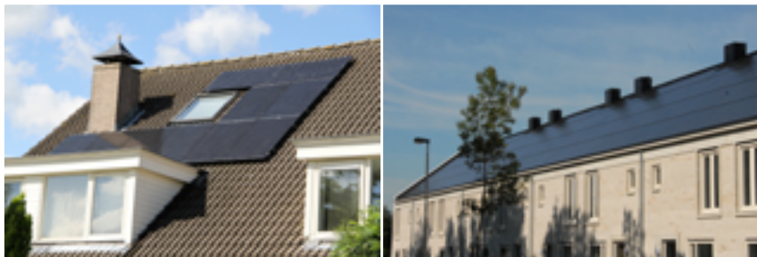
ZONNEPANELEN OP DAKEN; LINKS: ALS ADD-ON (BAPV); RECHTS: VOLLEDIG VERWERKT IN DAK (BIPV) (EEN ESTHETISCH FRAAIE BIPV OPLOSSING VAN AERSPIRE)
